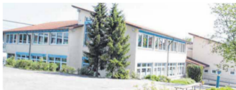
Die markanten Neubauten oberhalb der Schule sind fertig (oberes Bild). Jetzt richtet sich der Blick auf die Gebäudetrakte unten. SZ-FOTOS: DREHER
